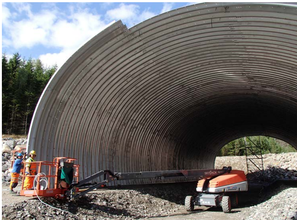
Över den nya vägsträckan mellan Viared och Kråkered utanför Borås byggs en 38 meter lång faunatunnelbro med 14 meters bredd och nio meters höjd där viltet skall passera utan att störas av trafiken. Foto: Trafikverket
