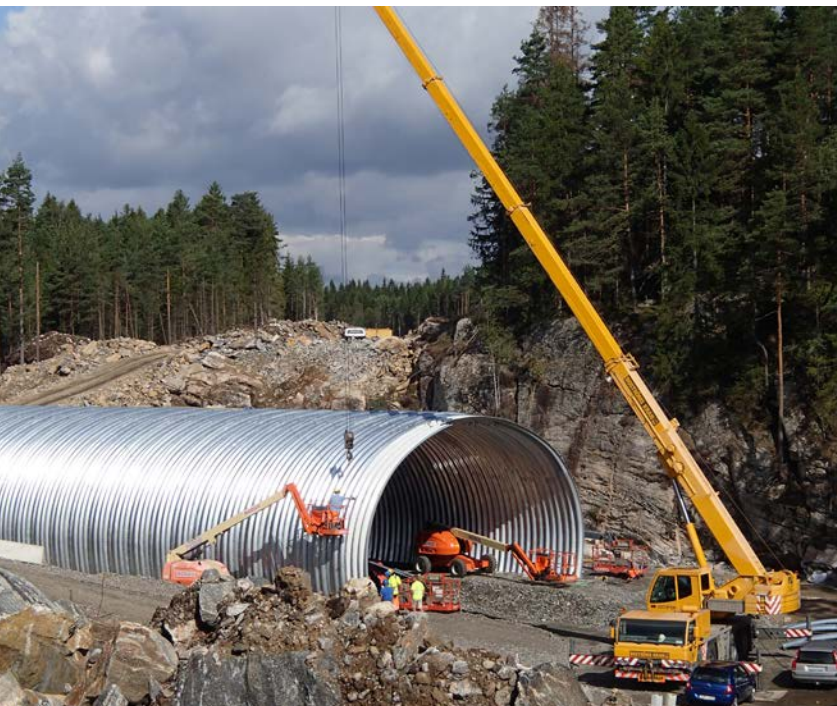
Ett stort riskmoment är sprängningsarbetet som måste göras för att vägen skall kunna gå genom terrängen. En av de största utmaningarna var sprängningarna under Vattenfalls luftburna 130 kilovoltsledning.
