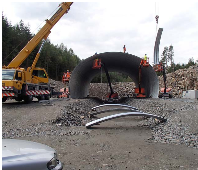
Vägområdet mellan Viared och Kråkered består till stor del av orörd terräng. Trafikverket, NCC och Borås Kommun har arbetat intensivt med att bevara miljön i så stor utsträckning som möjligt.
